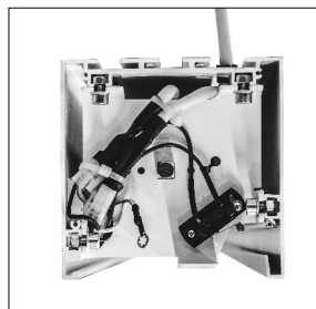
Elektroinstalace včetně dodatečného mikrosplínače
